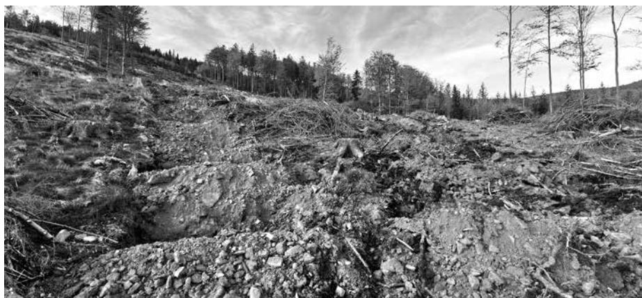
6) Hloubka zasakovacích jam a šířka stabilizačních hrázek se odvíjí od sklonu terénu. Čím je prudší svah, tím jsou jámy hlubší a hrázky širší. U zasakovacích pásů může být vrpy bagru hluboký až 1,5 m. Dešťová voda se v jámách neakumuluje, ale okamžitě vsakuje hluboko do země.
