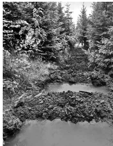
5) Čelní pohled na rekultivovanou nepoužívanou přibližovací linku systémem tůní, který brání kontinuálnímu odtoku povrchové vody po jinak ztuhnělé lince.
