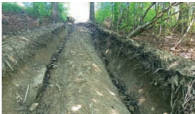
Obr. 1: Zahlubující se linka na stahování dřeva
