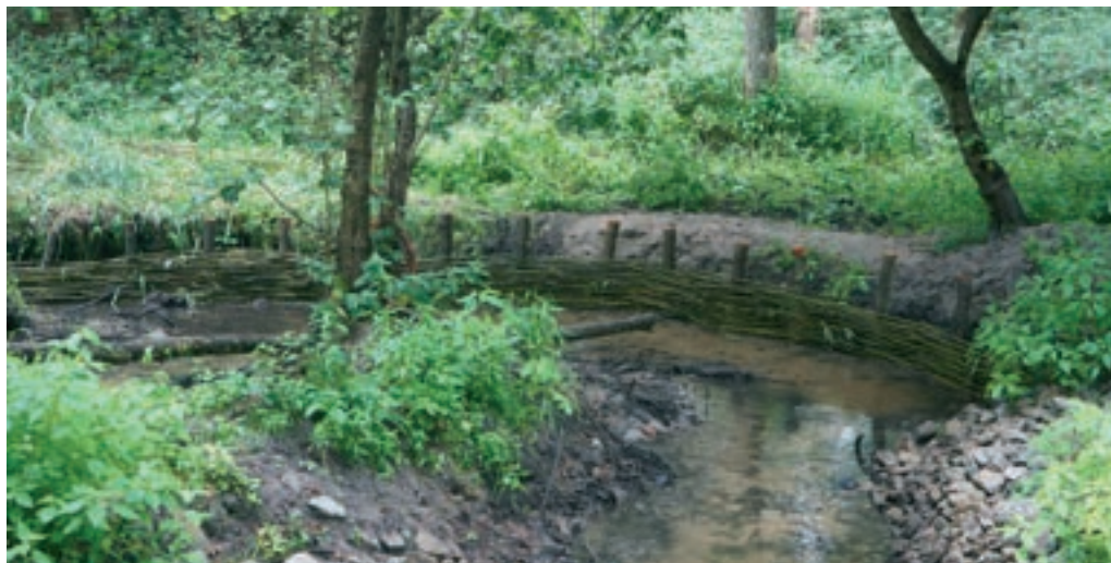
Úprava brehu rybieho obchvatu na Rudave zapletaným oplôtikom
