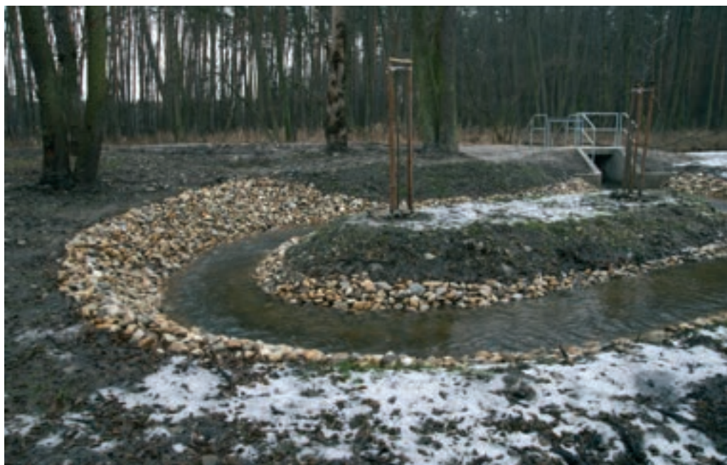
Obr. č. 3: Rybovod na rieke Rudave pri obci Veľké Leváre, foto: D. Valachovič
